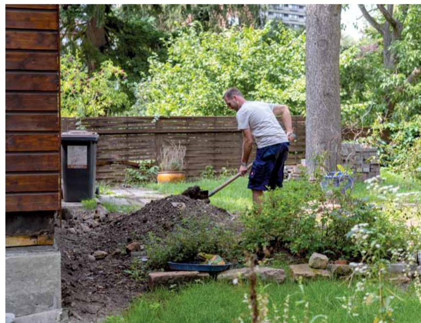
Auf der Baustelle wird viel in Eigenleistung gestemmt. Das Fleckenbühler Haustechnik-Team engagiert sich in besonderem Maß für die Sanierung des Gartenhauses, Fotos: die Fleckenbühler
